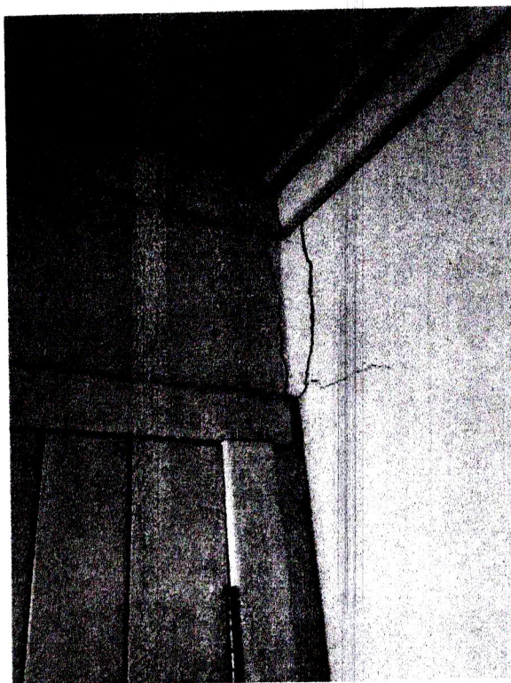
Figura 5 - Trinca (1)
